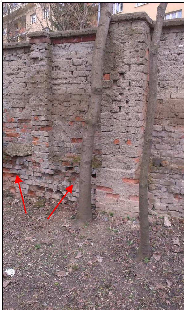
Dokumentace poškození zdících prvků stěny
