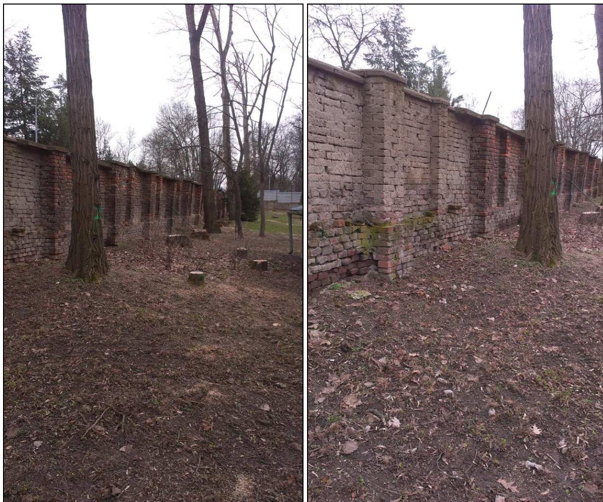
Celkový pohled na stěnu ze strany areálu PN BRNO
