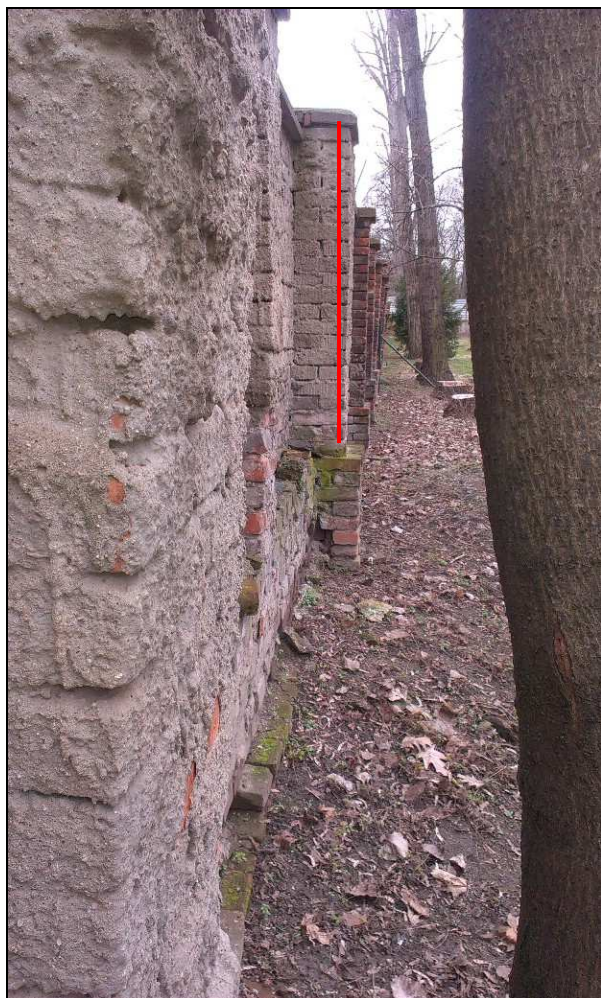
Zjevná deformace – vyklonění stěny
