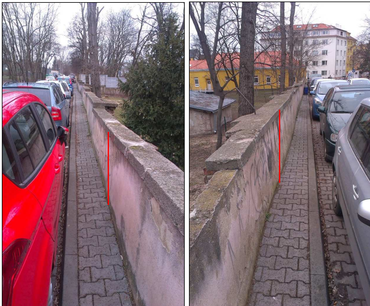
Pohled na stěnu z ulice Cornovova – patrné vyklonění stěny
